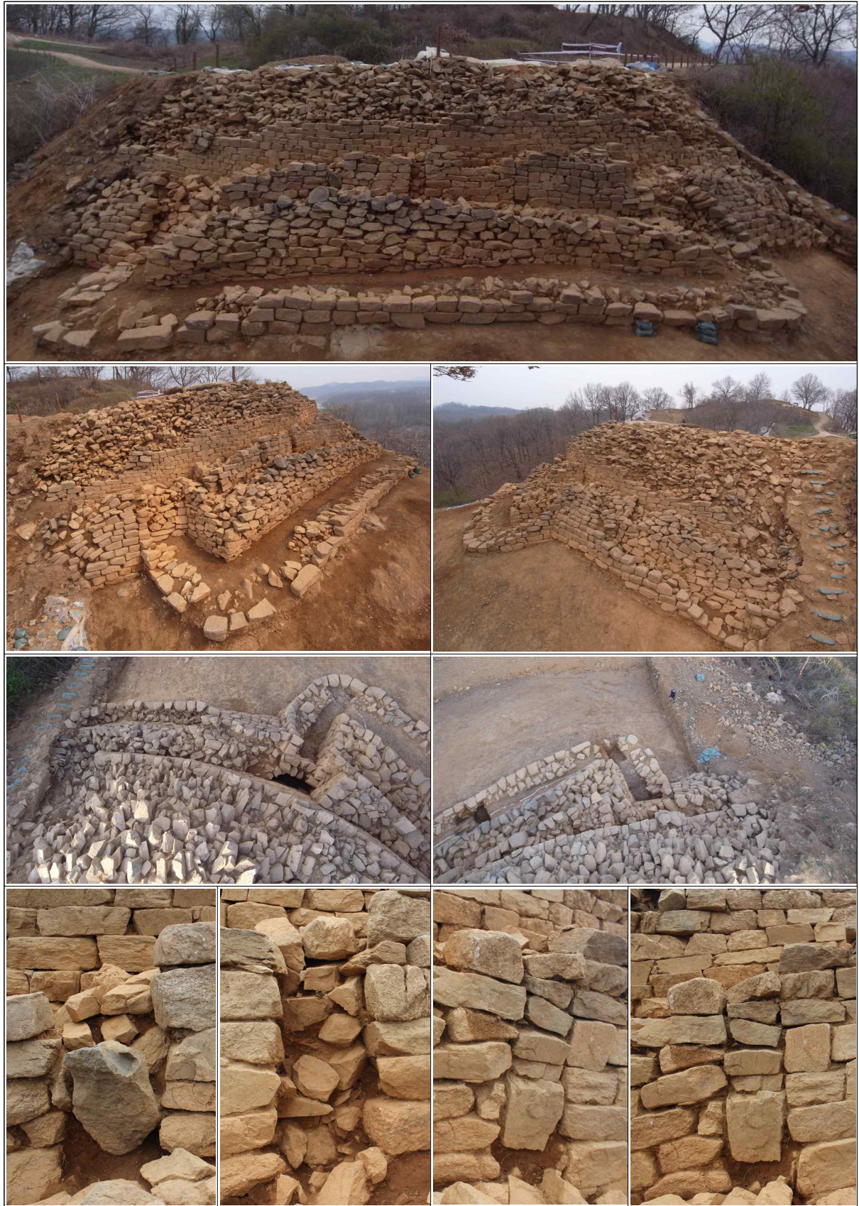
사진 3. 치2(남서쪽) 석축부 전경 및 세부
